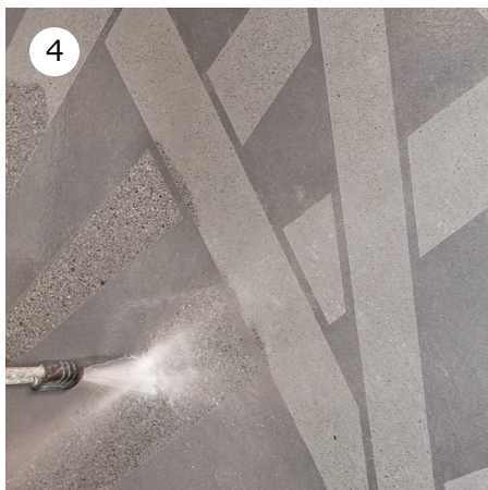
4 仕上げ面を圧水洗浄します。
